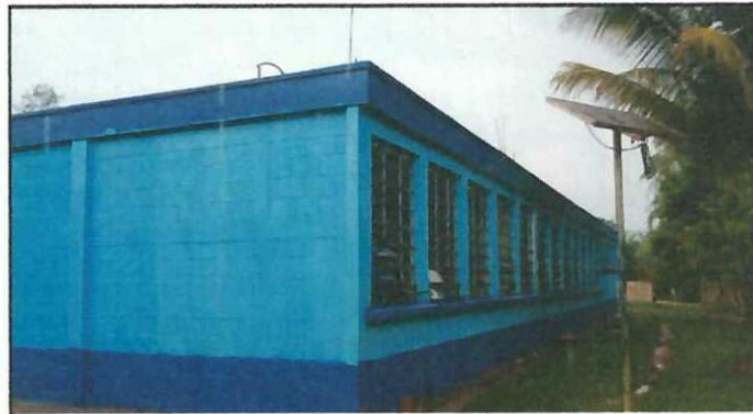
Foto 4: CUBIERTA DE LAMINAS. Se instalará cubierta de techo en exterior de aulas para evitar la filtración de agua de lluvia en las ventanas.
