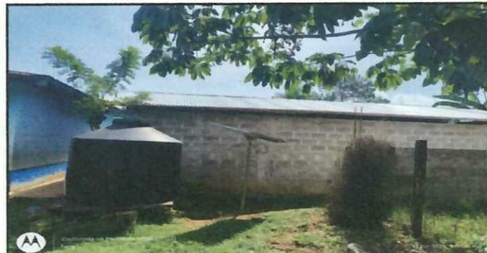
Foto 6: CAMBIO DE CANALES Y BASE DE TINACO. Se hará el cambio de canales debido que se encuentran en mal estado y la fundición de la base del tinaco existente.
