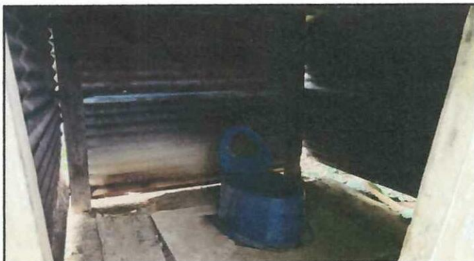
Foto 3: CAMBIO DE SANITARIOS PLÁSTICOS A LOZAS Y SUS ACCESORIOS. Se hará cambio de letrinas plásticas a sanitarios lavables con sus respectivos accesorios.
